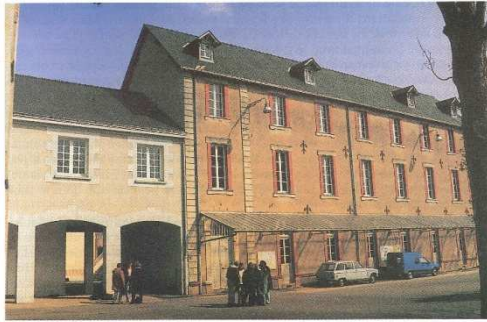
A droite, première construction 1894. A gauche, bâtiment à l'arcade 1973.
